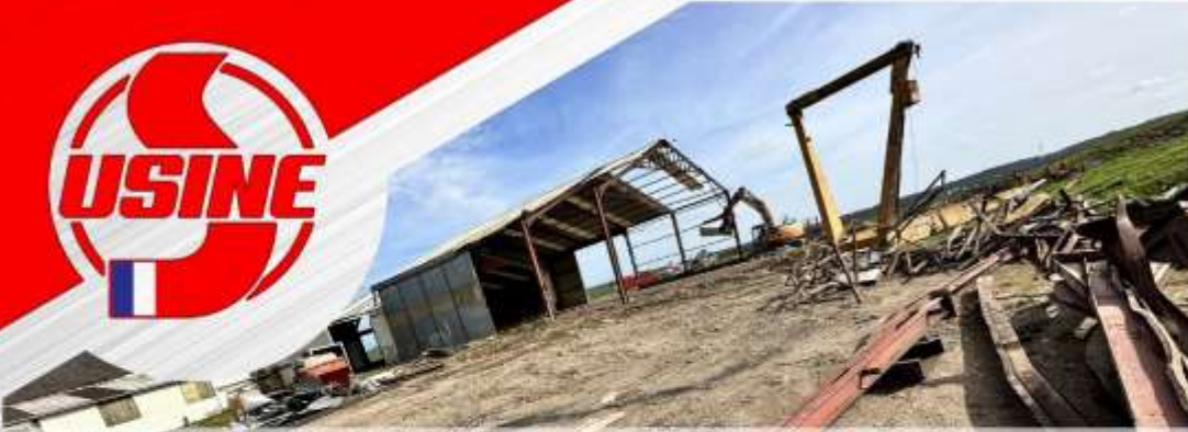
Avant toute construction, il y a souvent démolition...
