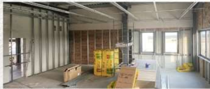
Réalisation de la partie bureau
