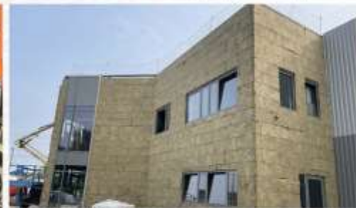
Isolation de la façade
