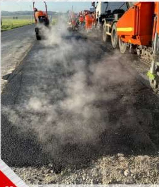
Enrobée tout chaud
