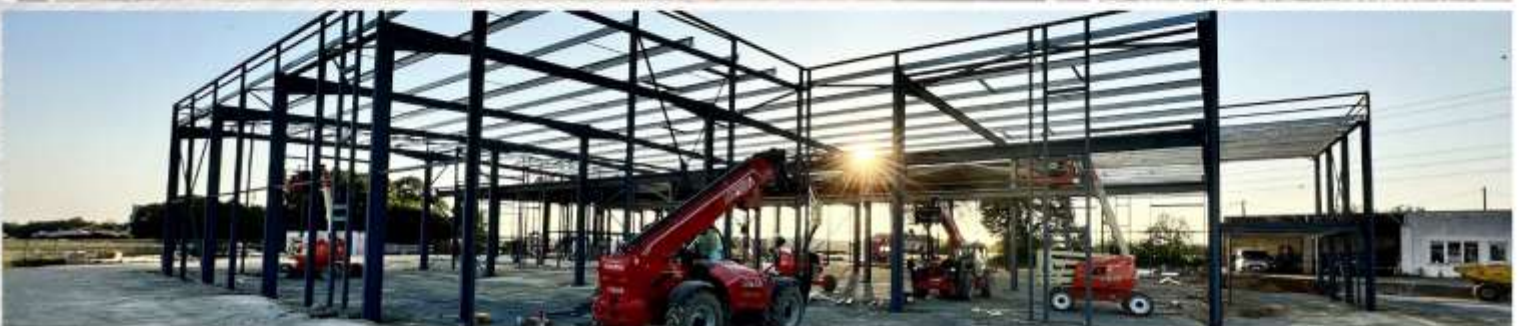
Quelques poutrelles pour un joli coucher de soleil
