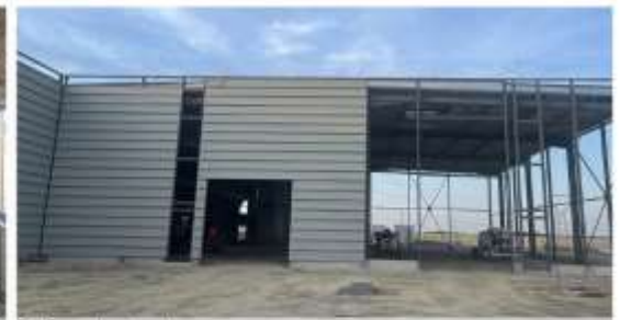
Pose du bardage
