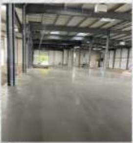
Dallage en cours
