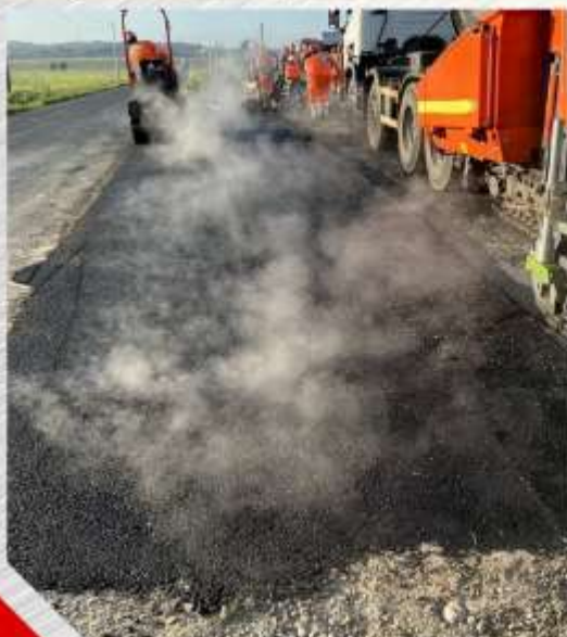
Enrobée tout chaud
