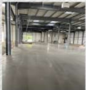
Dallage en cours
