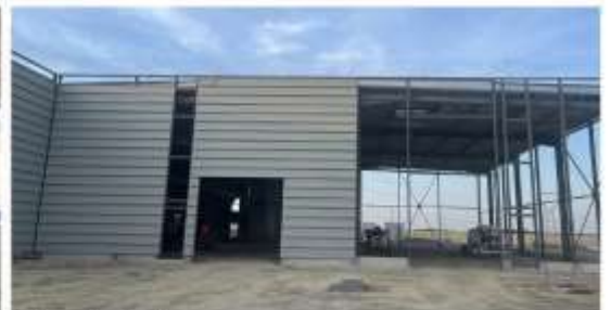
Pose du bardage
