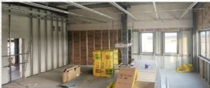
Réalisation de la partie bureau
